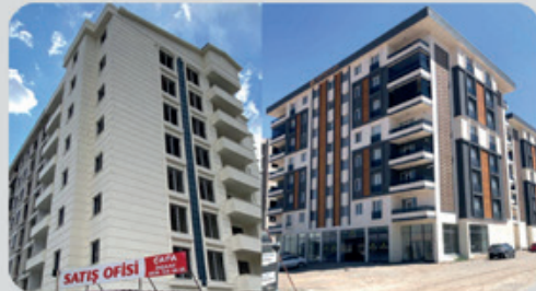
• SAF AKRİLİK DIŞ CEPHE BOYA UYGULAMASI
