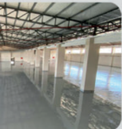
• EPOKSİ ZEMİN KAPLAMA BOYA UYGULAMASI
