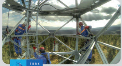
• BÖLGE İKMAL DİREKLERİ ÖZEL ÇİNKO EPOKSİ BOYA UYGULAMASI
