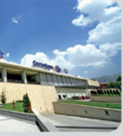
• SU BAZLI İÇ VE DİŞ CEPHE BOYA UYGULAMASI
