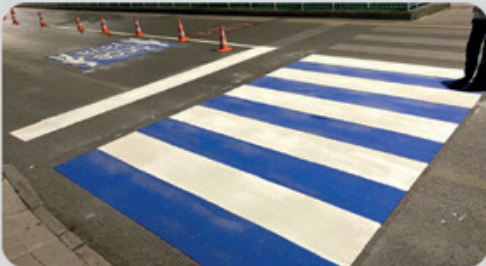
• METİLMETAKRİLAT YOL ÇİZGİ BOYA UYGULAMASI
